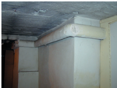
Voorbeeld ongebonden toepassing: plasterislatie
