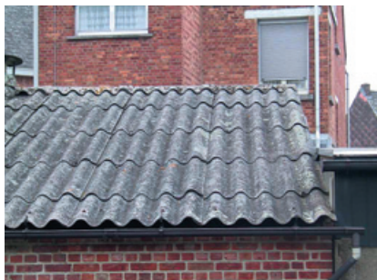
Voorbeeld hechtgebonden toepassing: golfsplaten
